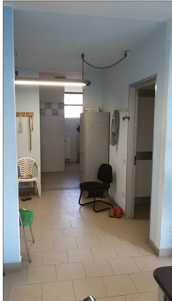
Vista interna area spogliatoi e servizi
