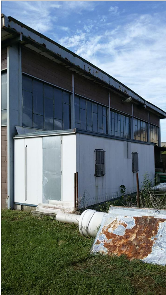
Vista esterna del capannone e container prefabbricato (lato nord)
