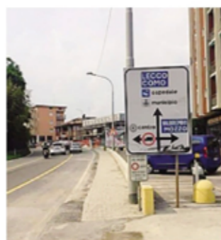
Il nuovo marciapiede
