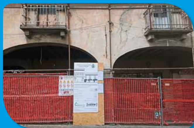
NOVEMBRE 2020 - INIZIO LAVORI
