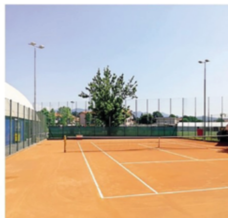
Il campo da tennis: è stato installato un nuovo sistema d'irrigazione
