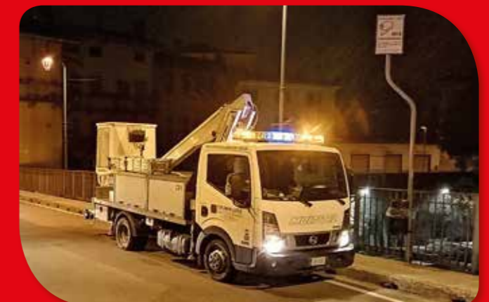
NOVEMBRE 2020 - INIZIO LAVORI LUGLIO 2021 - FINE PREVISTA DEI LAVORI
