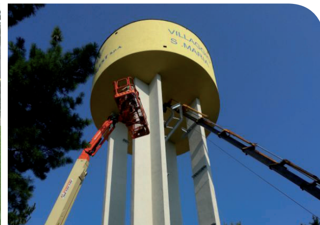
TORRE DELL'ACQUEDOTTO VILLAGGIO SANTA MARIA
