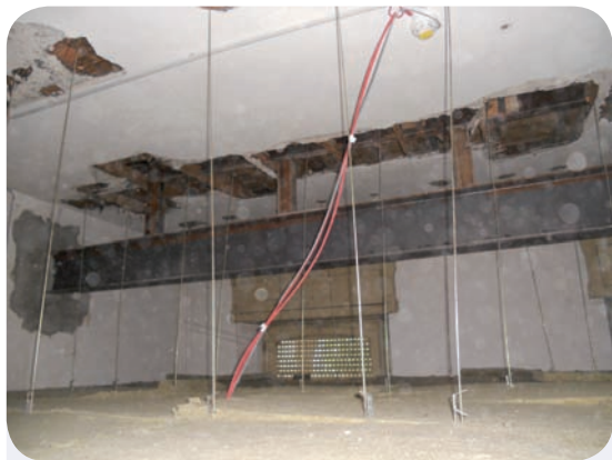
Foto n. 2: particolare della trave di rinforzo, della controsoffittatura e sensore antincendio di un'aula
