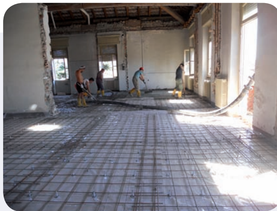
Foto n. 3: realizzazione open space e solaio in calcestruzzo armato al primo piano
