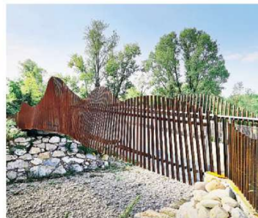
La passerella ciclopedonale sul torrente Quisa inaugurata nel 2022
